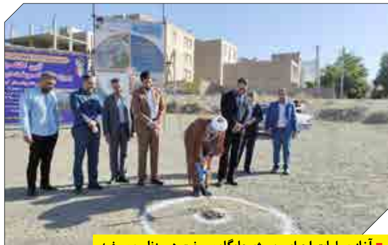
آغاز عملیات اجرایی پروژہ جایگاہ سوخت دومنظرہ سیفیہ
